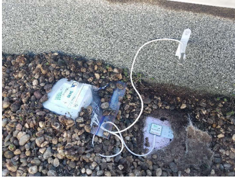
Abbildung 4 Schutz der Knoten vor Wassereintritt mit Plastiktüten und Entfernung von Kies, bis eine ebene und saubere Oberfläche erreicht ist.
